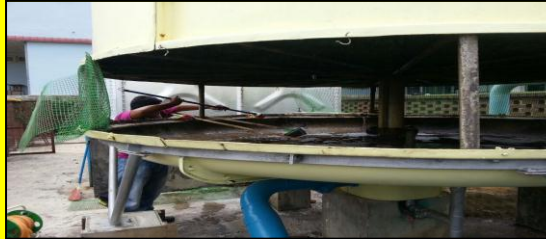
Penyelenggaraan 'Cooling Tower' di Pusat Sumber.
